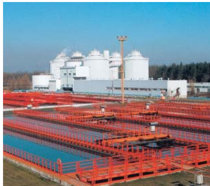
Oczyszczalnia ścieków „Czajka”
