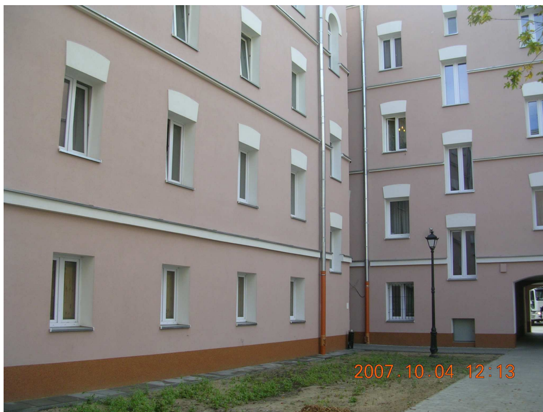
Ryc. 15. Budynek przy Lubelskiej 30/32 po modernizacji
