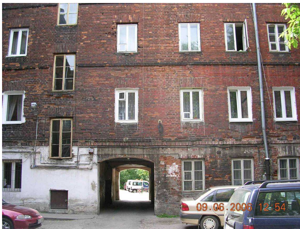
Ryc. 14. Kamienica przy ul. Lubelskiej 30/32 przed modernizacją
