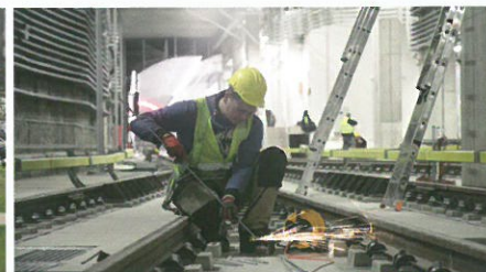
Budowa II linii metra
