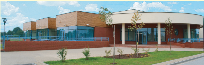
Budowa przedszkola przy ul. Ostródzkiej (Białoleka)
