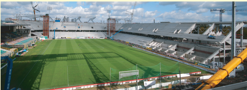
Budowa stadionu przy ul. Łazienkowskiej
