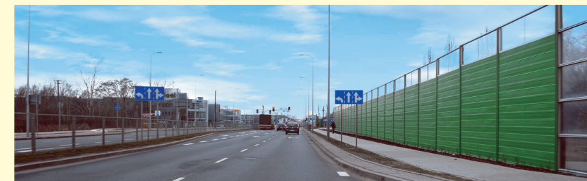
Przebudowa ul. Poleczki na odc. ul. Puławska – ul. Osmańska
