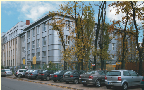
Modernizacja i rozbudowa Szpitala Inflancka
